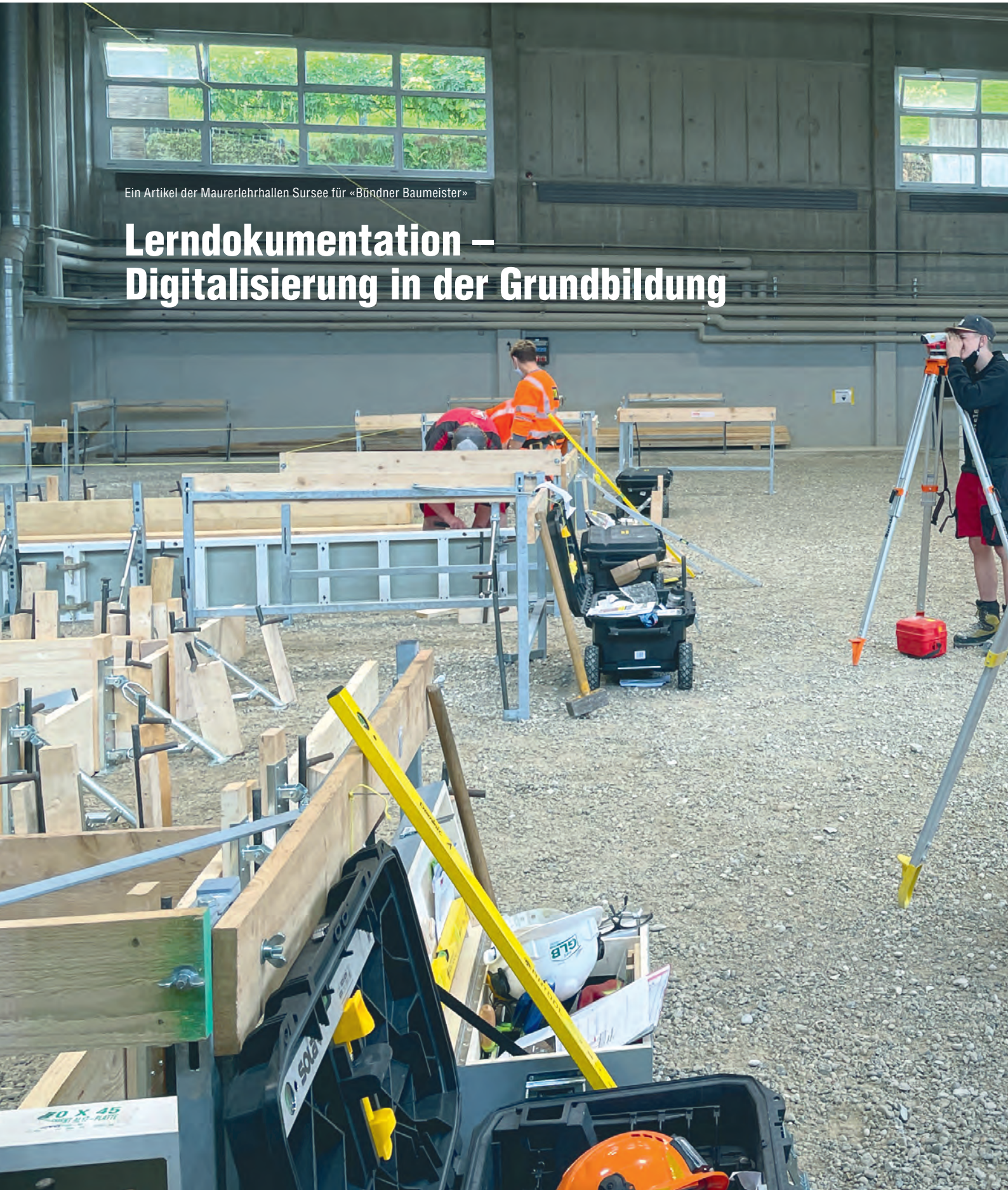
Bild: Höhenkontrolle einer Bodenplatte
