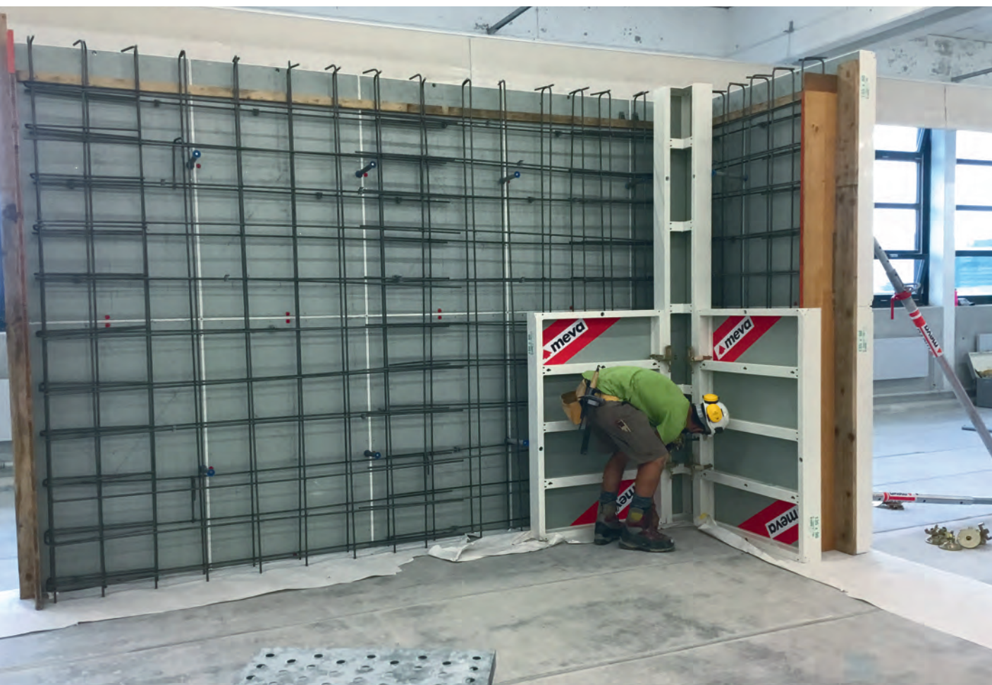
Bild: Zuschalen mit einer Rahmenschalung
