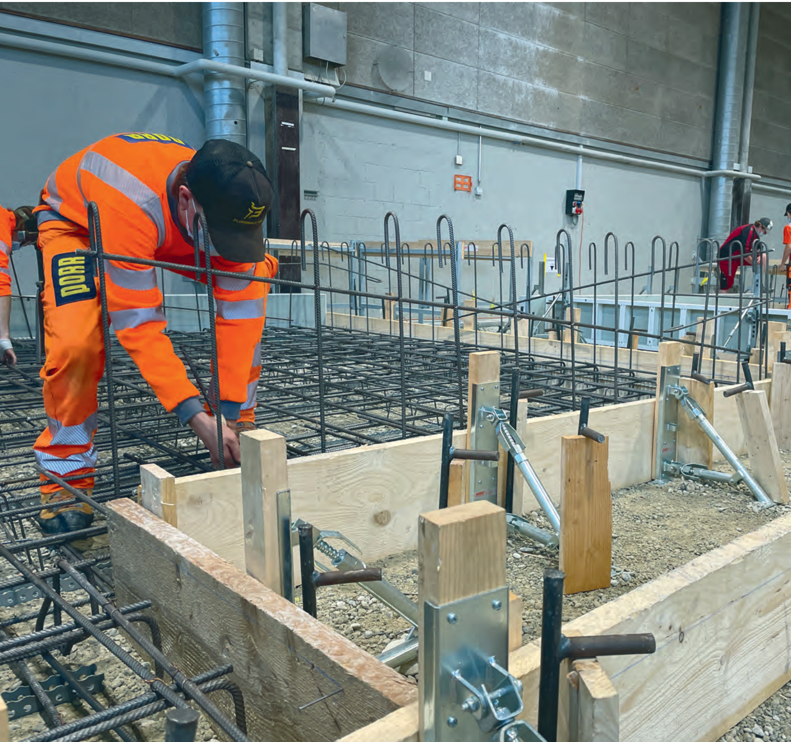
Bild: Lernender beim Binden der Bewehrung
