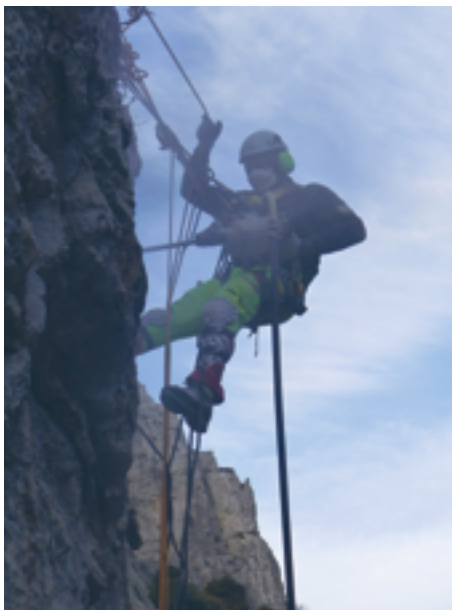
Bohrarbeiten am hängenden Seil
