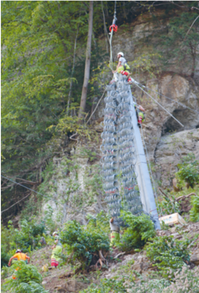
Montage Steinschlagschutznetz
