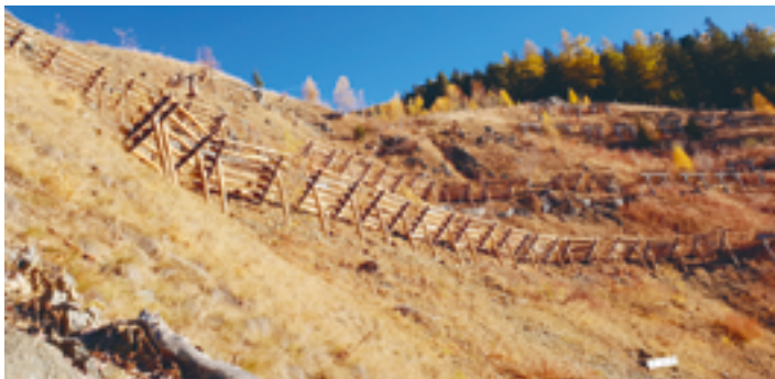
Lawinverbauung Barcli, Zernez rempar grischun ©
