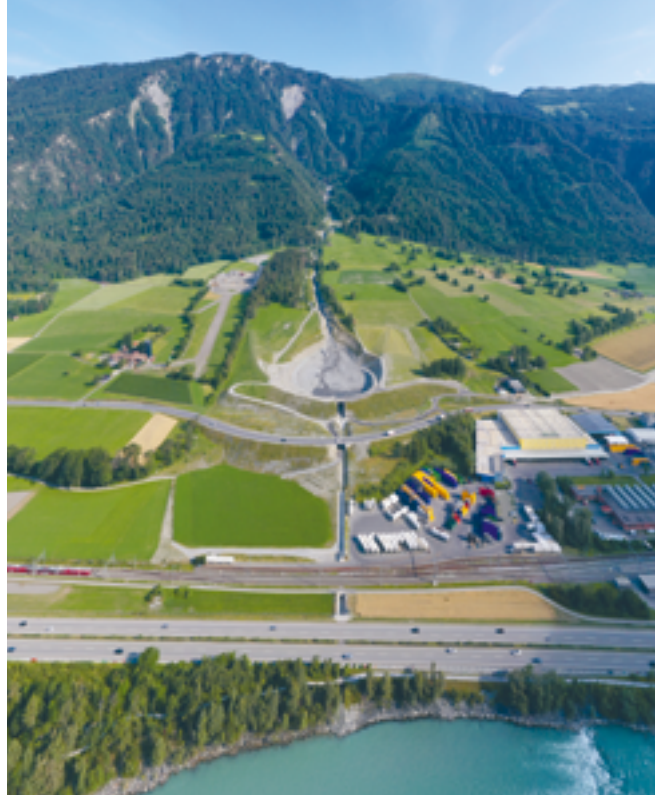
Schutzbauwerk Val Parghera, Domat/Ems Bild: bilder.gr
