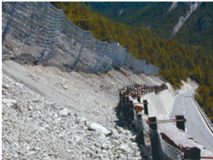
Bild: Steinschlagverbau Falla da l'uors an der Ofenpassstrasse
