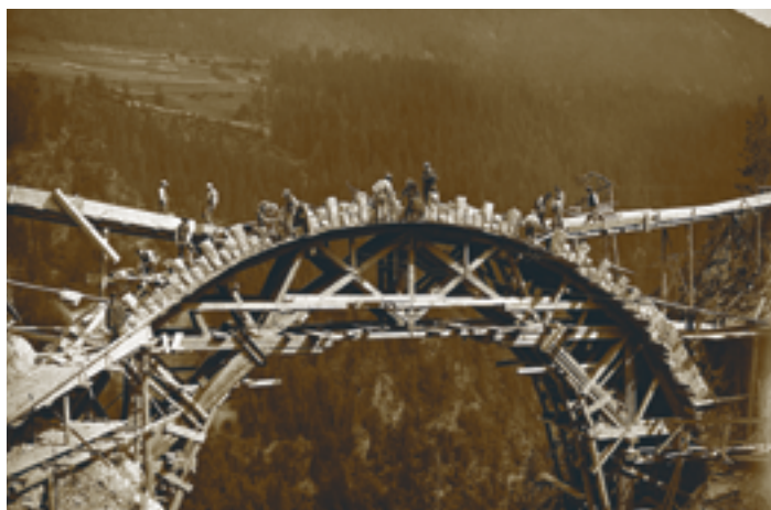
Das präzise Behauen der Steine galt als eine besondere Fertigkeit der Bauarbeiter, 1908 Bild: Archiv RhB
