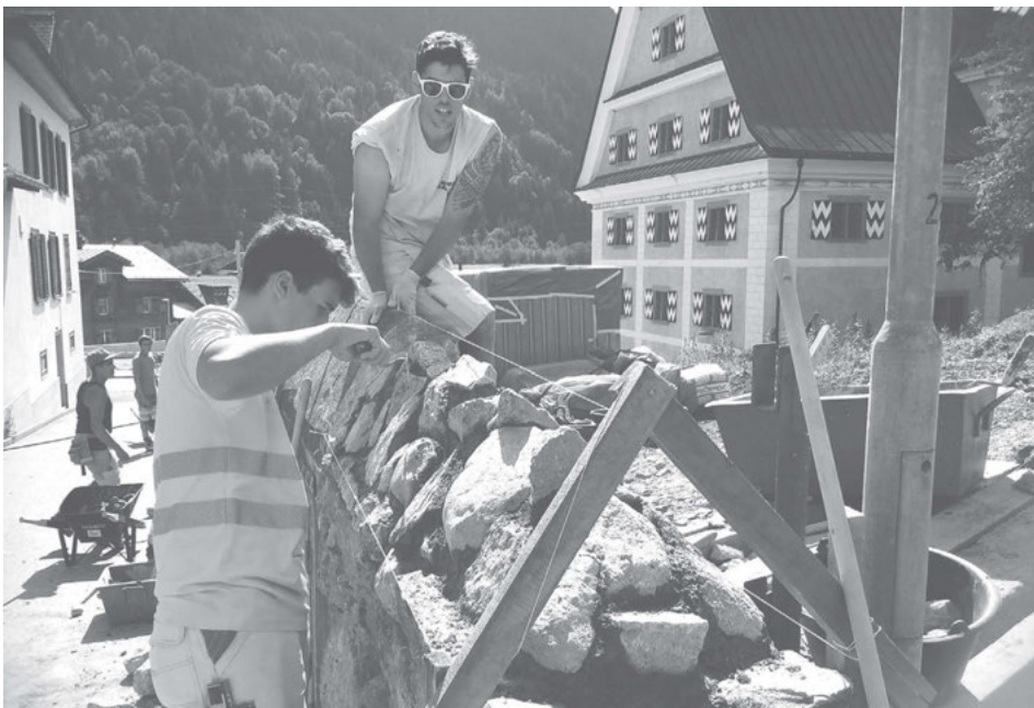
Lehrlingseinsatz Sanierung Umfassungsmauer Cuort Ligia Grischa, Trun.
