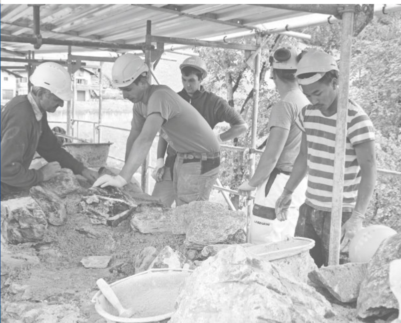
Lernende Maurer und Baupraktiker sichern Ruine Castels in Putz
